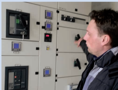
Luigi Rezzola nella sala controllo dell'impianto di biogas
