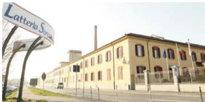
Esterno della cooperativa di trasformazione Latteria Soresina
